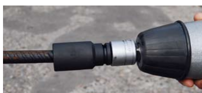
Het opzetstuk op de slagmoersleutel plaatsen. Aan de andere zijde op de stekeind-wapening zetten.
